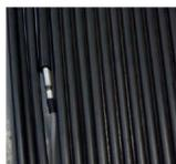
» Instalação do sensor de temperatura no coletor solar: O sensor deve ser instalado no coletor em um lugar onde não exista obstáculos que possam ocasionar sombra, mascarando a incidência da radiação solar sobre o mesmo.
